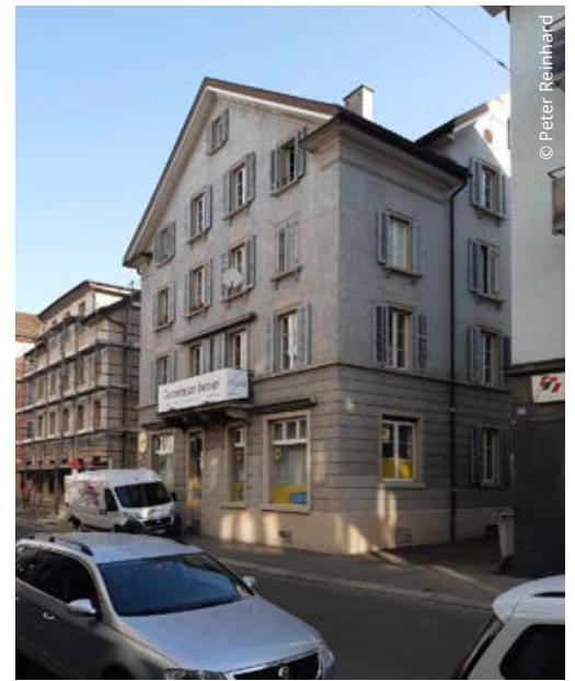
Die Liegenschaft Josefstrasse 32 vor der Sanierung
